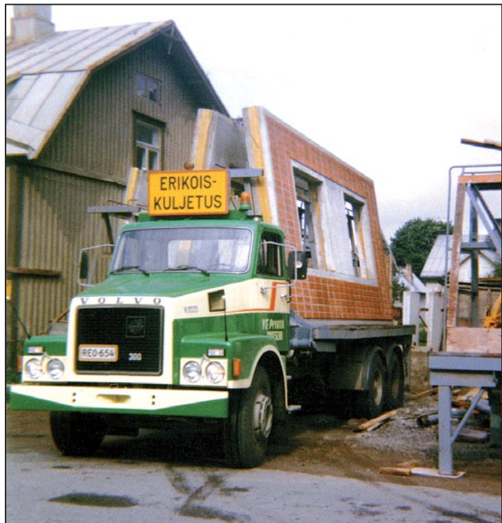
Yrjö Pyyhtiän Volvo-kuorma-auto rakennuselementtikuormassa v. 1980 työmaalla Lappeenrannassa
